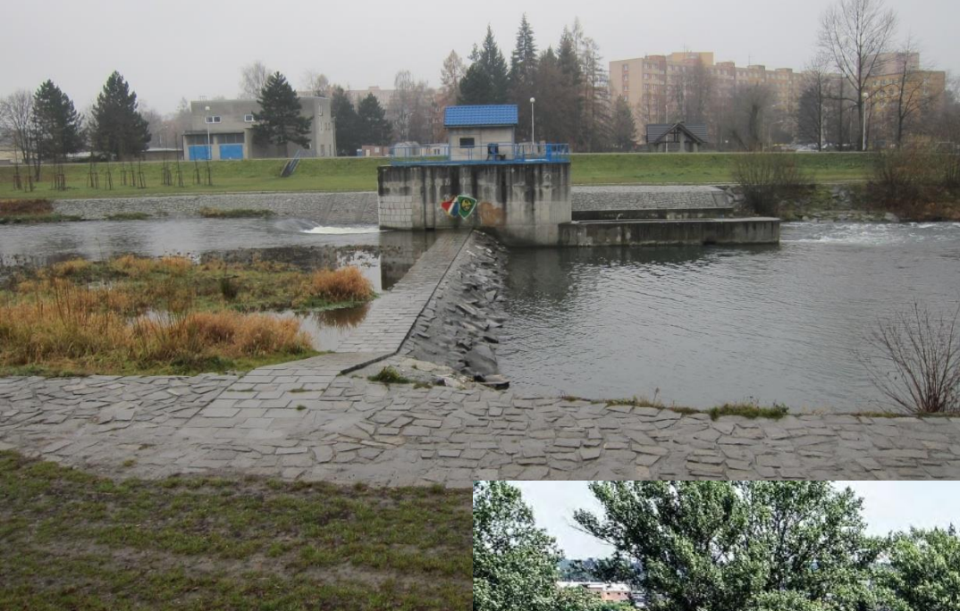
Stávající stupeň s nevyužitým hrazením na LB – pohled z pravého břehu
